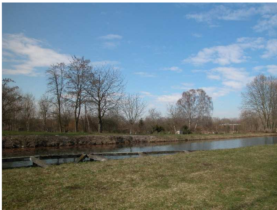
Illkirch nord, le canal du Rhône au Rhin (67) [140 m] le 19 Mars 2009
