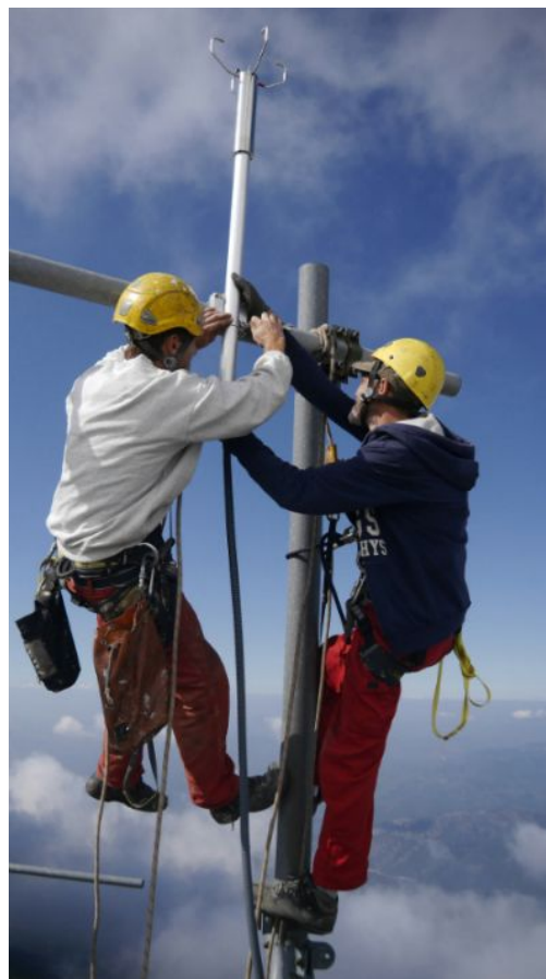
installation par les cordistes de Profil'Accro ↑
